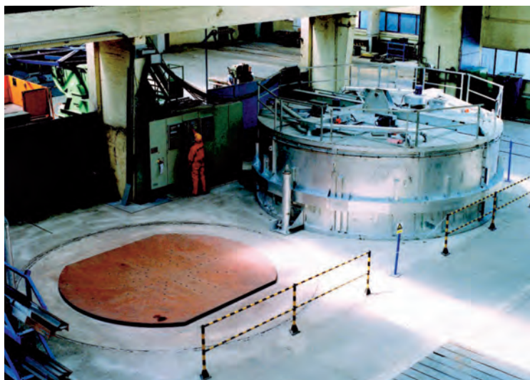
Fourneau circulaire à chauffage électrique
