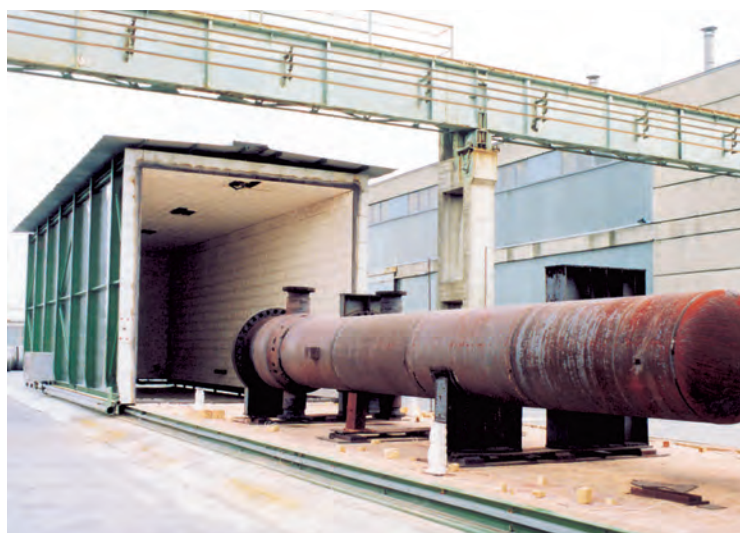
Fourneau de recuit chauffé au gaz pour le recuit de détente de grands récipients
